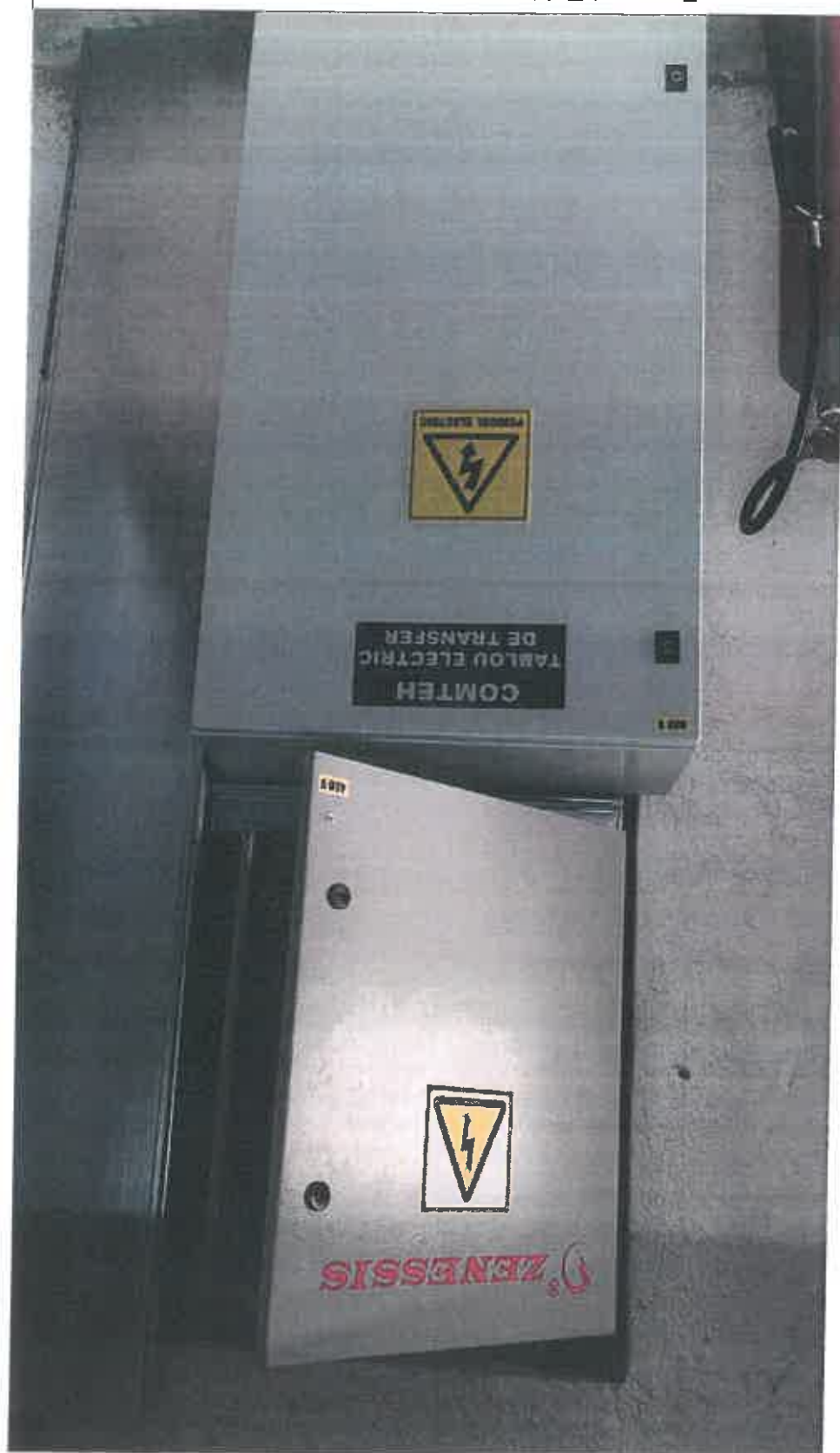
Foto nr.4 Tablou electric de transfer si AAR
