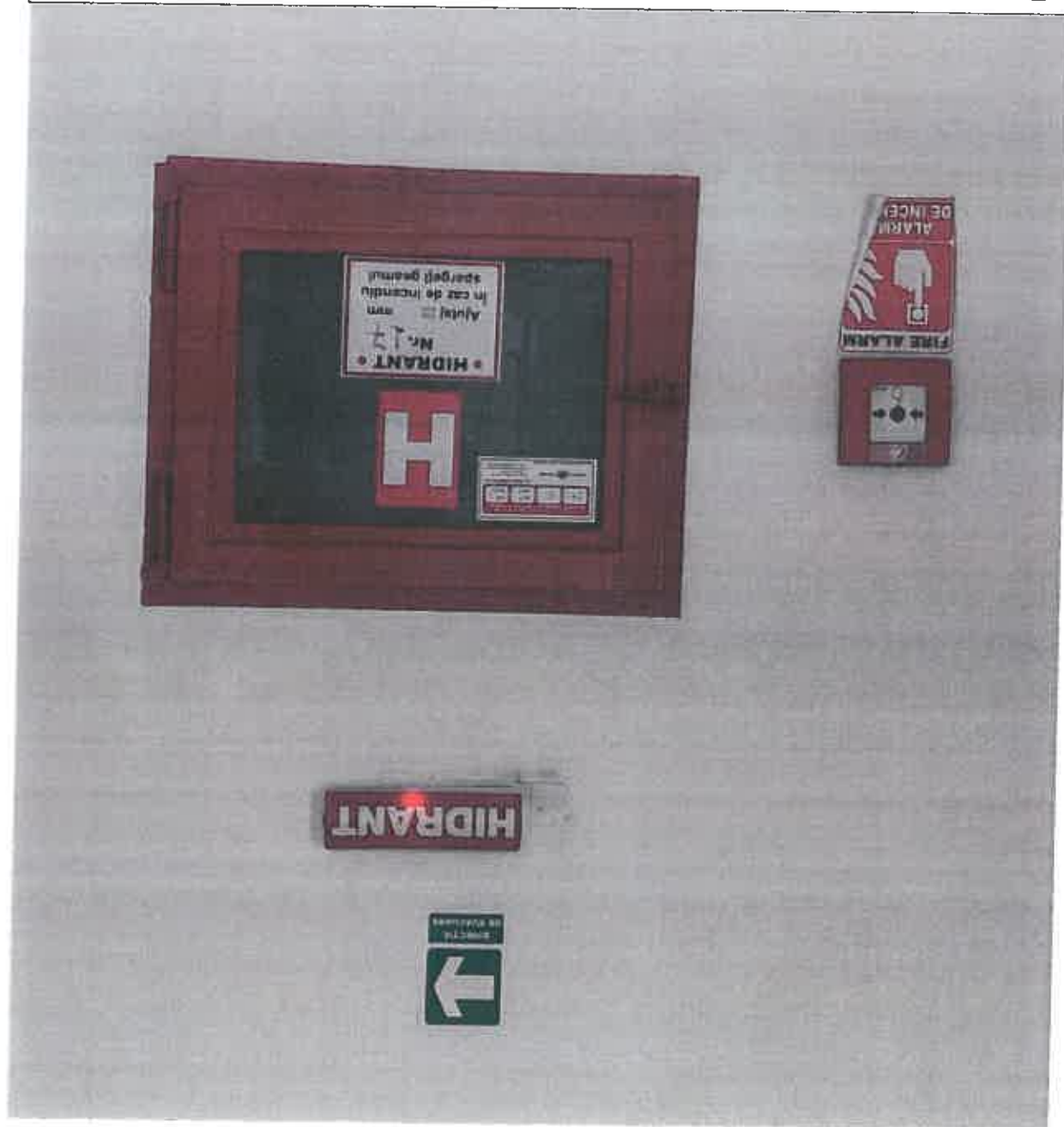
Foto nr. 19 Iluminat de siguranta marcare hidranti si buton manual de alarmare in caz de incendiu
