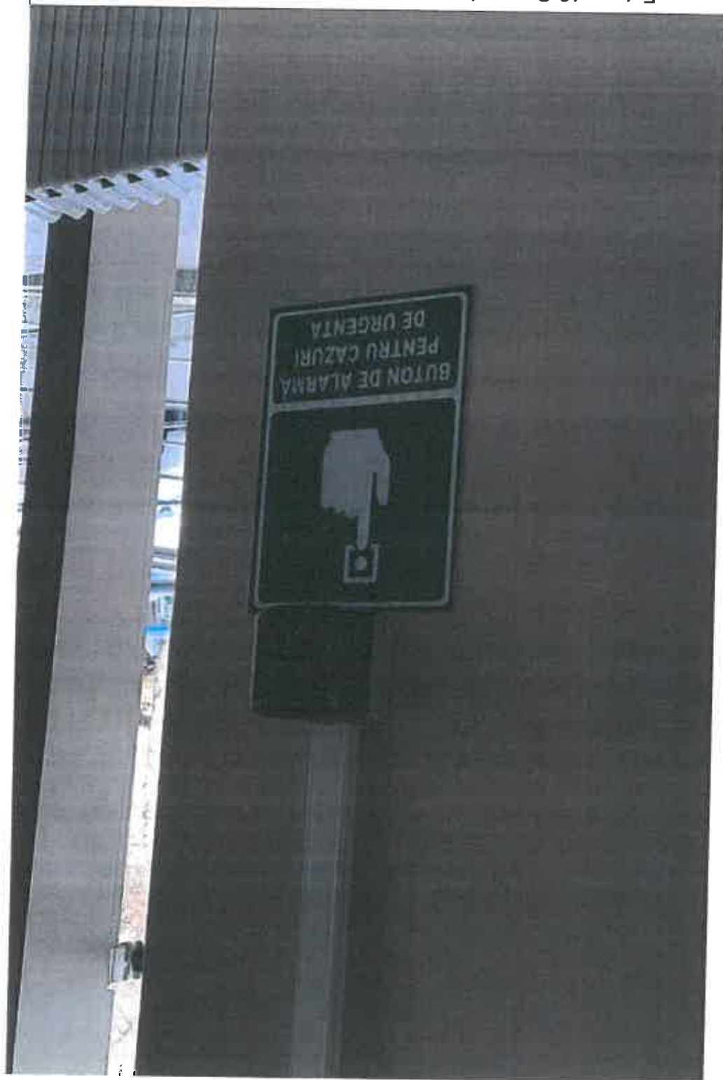
Foto nr.18 Comanda pornire manuala iluminat anti-panica
