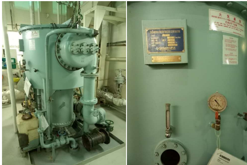
Figura 5.1 Generator de apă tehnică tip SASAKURA KM50
