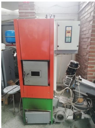
Fig. 13. Cazanul de ardere în strat fluidizat
